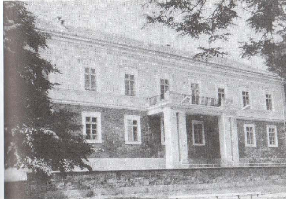
Budynek zamku w Beneszowie Dolnym – tylne skrzydło.
