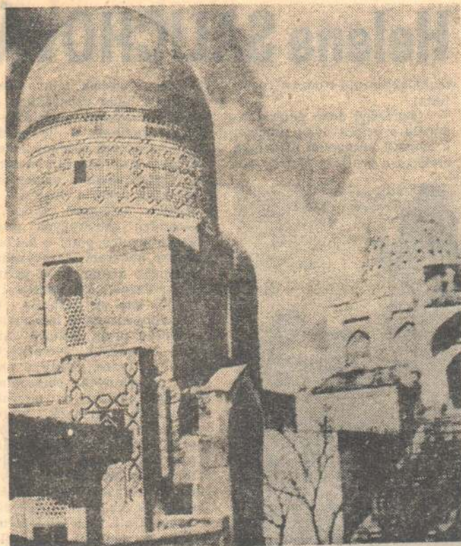
▲ Jeden z nejkrásnějších stavebních celků Samarkandu — mauzoleum Šáh-i-Zindeh.
